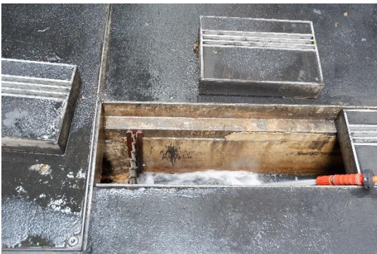
ภาพที่ 2.2-18 ลอกท่อระบายน้ำบริเวณพื้นที่โครงการ
