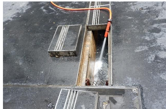
ภาพที่ 2.2-18 ลอกท่อระบายน้ำบริเวณพื้นที่โครงการ
